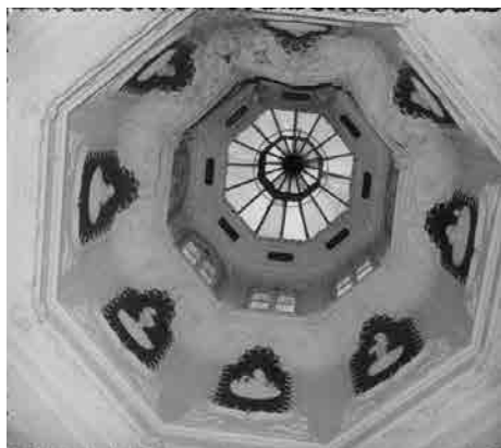
Figura n.º 4 A clarabóia existente no Palacete da Granja (Arquivo Particular)
